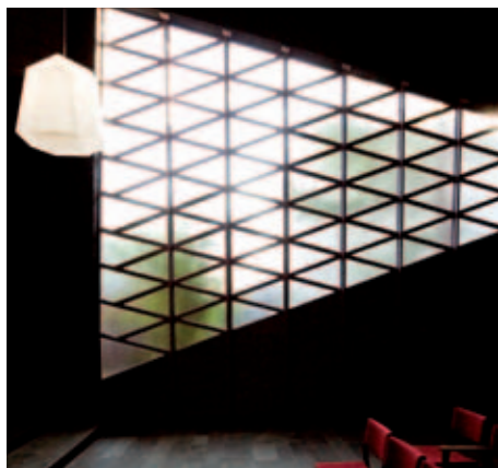
Lichtwand-Sanierung (rechts: Modell)
