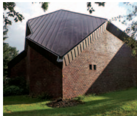
Dach vor und nach der Sanierung
